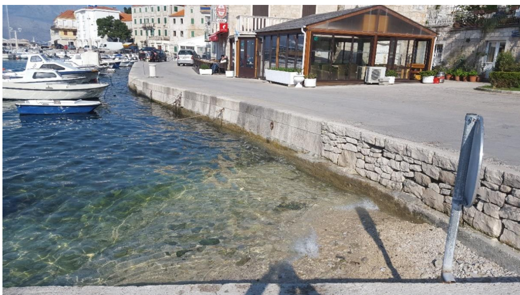
Slika 3.1.-2.: Postojeći izgled obalnog zida luke Postira (pogled prema sjeveru)
